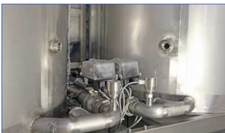
Kontinuierliche Füllstandsmessung und Motorkugelhähne
